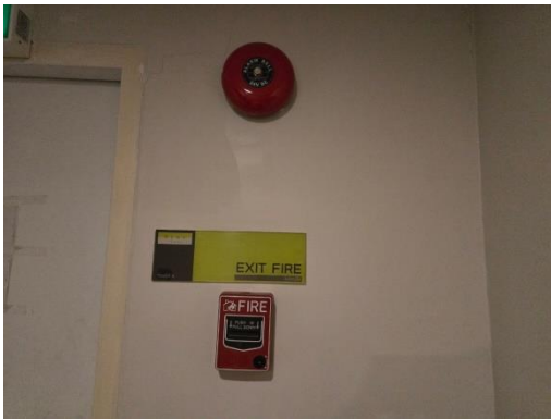
รูปที่ 2-30 สัญญาณแจ้งเตือนแบบกริ่ง และอุปกรณ์แจ้งเตือนเหตุแบบมือดึง
