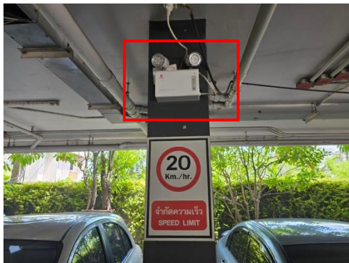
รูปที่ 2-32 เครื่องสำรองไฟ
